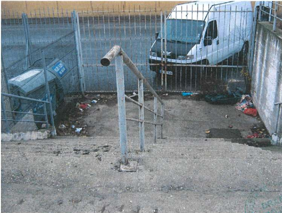
Vedere exterioara – acces pietonal platforma dalata soclu beton/ zid de sprijin
