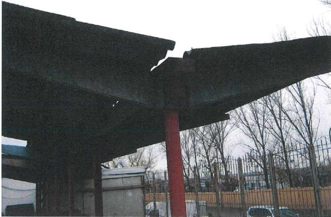
Vedere exterioara – Sopron Spalator matalic - Constructie C2
