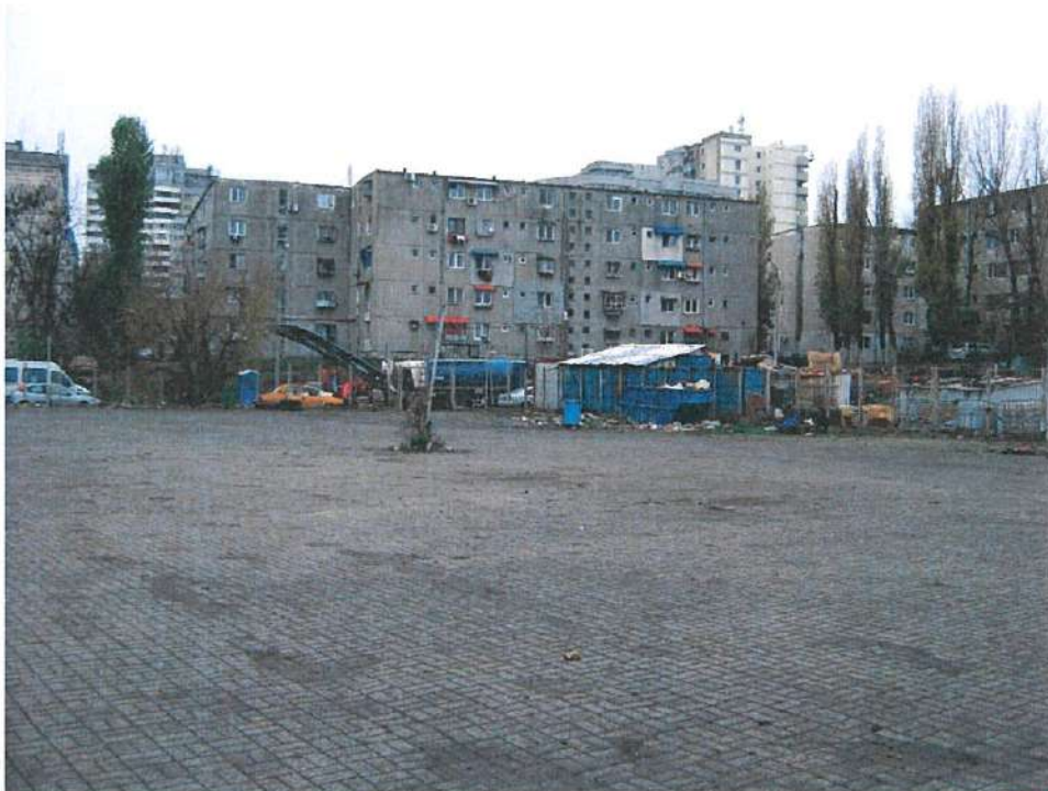
Vedere exterioara – platforma dalata si imprejmuire din gard metalic transparent.
