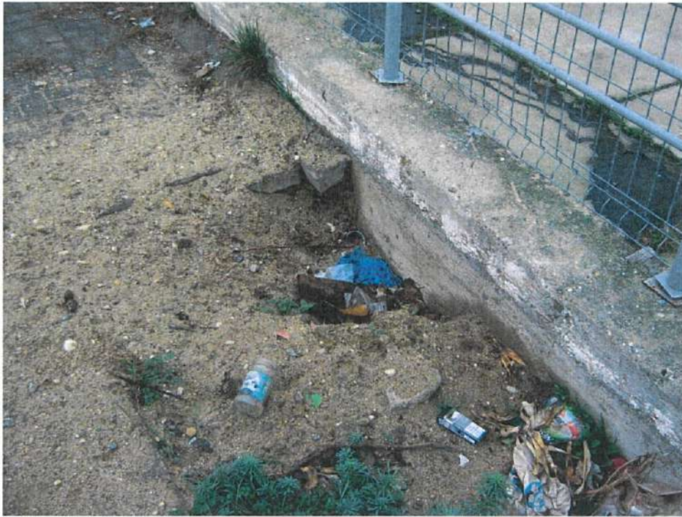
Vedere exterioara – platforma dalata – soclu beton/ zid de sprijin
