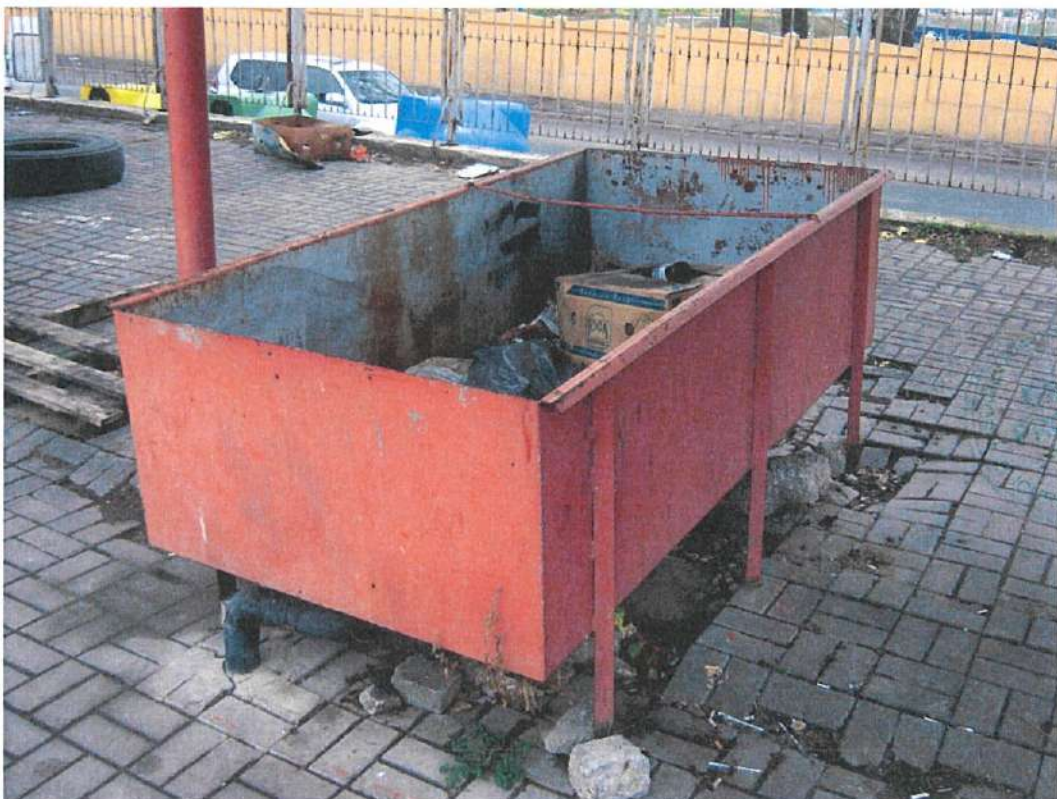
Vedere exterioara – Sopron Spalator matalic - Constructie C2
